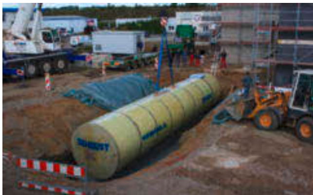
Einbau des Niedertemperaturspeichers.
